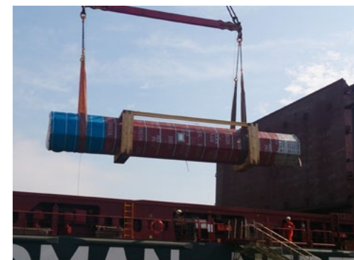
Verschiffung der Stützen
