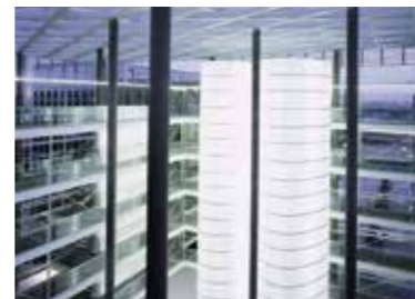
VHV Versicherungen Hannover: Stützen mit 25 m Länge und Ø 0,45 m
