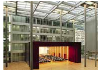
Haus der Ärzteschaft Düsseldorf: Gesamte Dachentwässerung innenliegend
