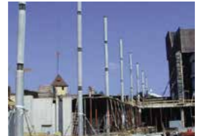
FAU Erlangen-Nürnberg: Einteilige Stützen mit 16 m Länge
