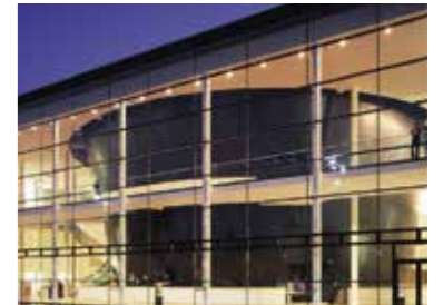
Theater Erfurt: Komplette Glasfassade über eingeschleuderte Stahlplatten angebunden
